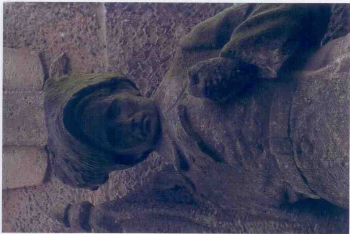
Čelní pohled na pomník se sochou vojína – povrch kamene je poškozen tmavými depozity, především v obličejové části vojína.
