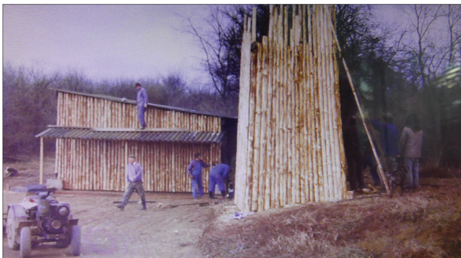
Počátky budování střelnice, rok 1998
