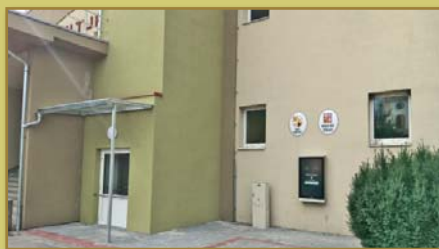
Výtah u kulturního domu
